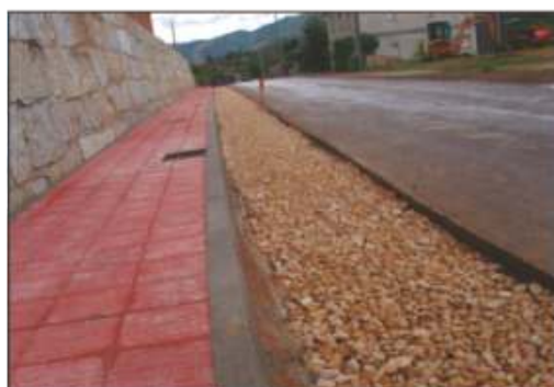
Carreteras y viales. Muros de contención.
