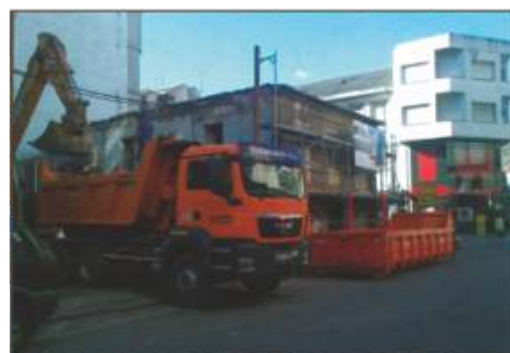
Excavaciones y demoliciones.
